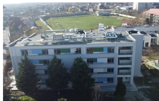
Eficientizare energetică a clădirilor din incinta Liceului Tehnologic "Dimitrie Bolintineanu" - Lucrări în derulare
