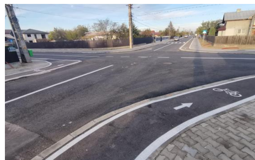
Reabilitarea și modernizarea străzilor Etapa II – Lucrări în derulare
