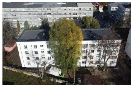
Eficientizare energetică a blocurilor de locuințe din orașul Bolintin-Vale - Lucrări în derulare
