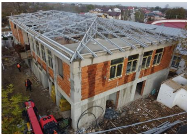
Reabilitare, modernizare, extindere, echipare Școala Gimnazială nr. 1 Malu Spart – Lucrări în curs
