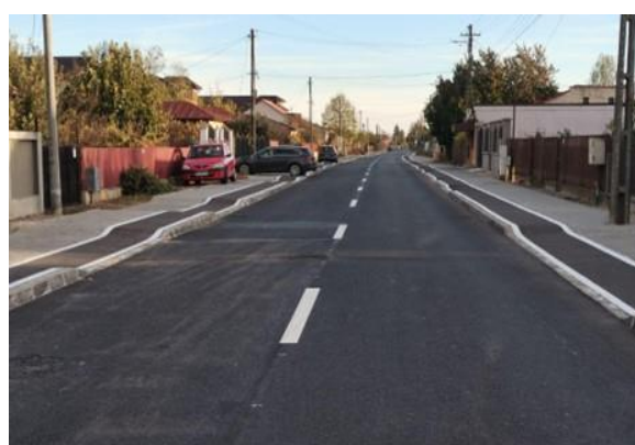
Reabilitarea și modernizarea străzilor Etapa II – Lucrări în curs
