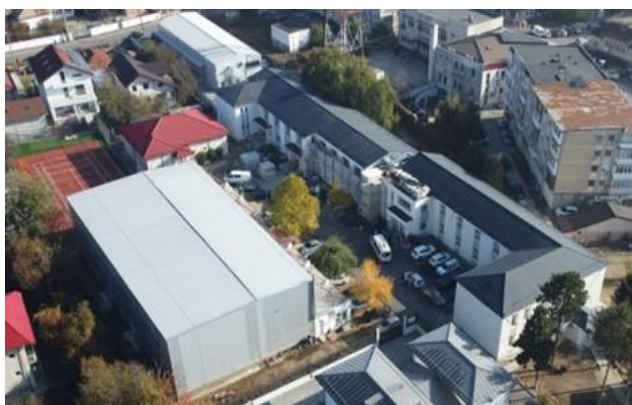
Extinderea și modernizarea Școlii Gimnaziale nr. 1 Bolintin-Vale, teren de sport – Lucrări în curs
