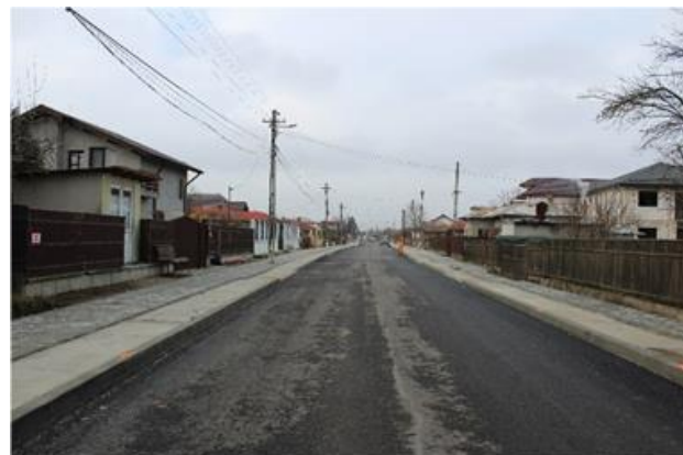
Strada Dimitrie Bolintineanu – lucrări de modernizare
