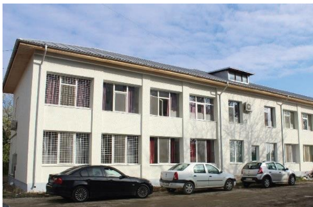
Izolarea termică a fațadei Secției de Pediatrie a Spitalului Orășenesc Bolintin-Vale
