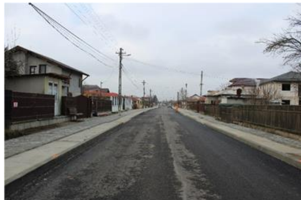
Strada Dimitrie Bolintineanu – Lucrări de modernizare
