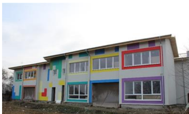
Grădinița Nr. 1 Bolintin-Vale- Lucrări în curs
