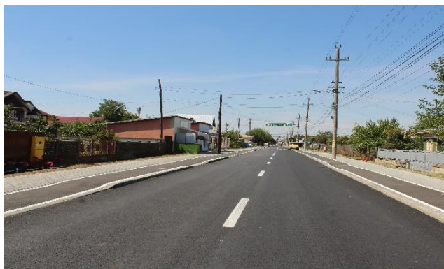
Reabilitarea și modernizarea străzilor, amenajarea pistelor de cicliști
