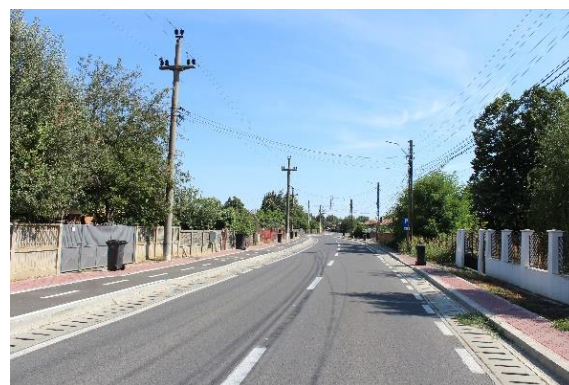
Lucrări de modernizare drumuri în Bolintin-Vale, str 23 August
