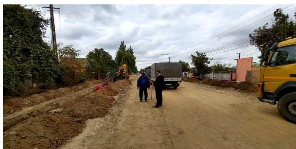
Asfaltare strada Republicii, Bolintin-Vale
