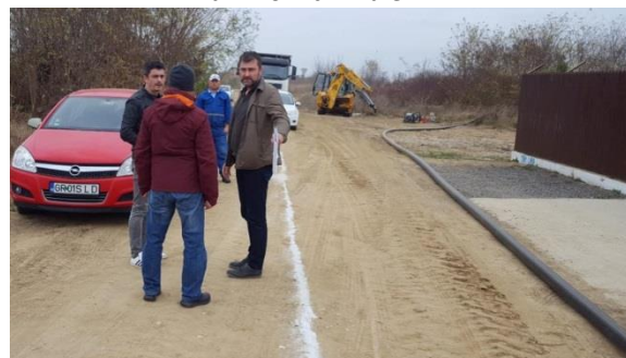
Lucrări de extindere rețele de utilități apă/canal/gaze/electricitate
