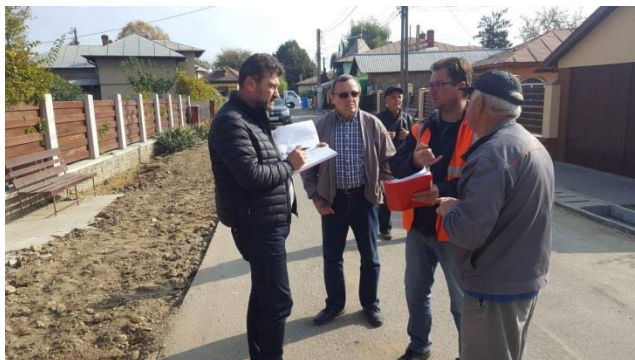
Lucrări de modernizare drumuri în Bolintin-Vale
