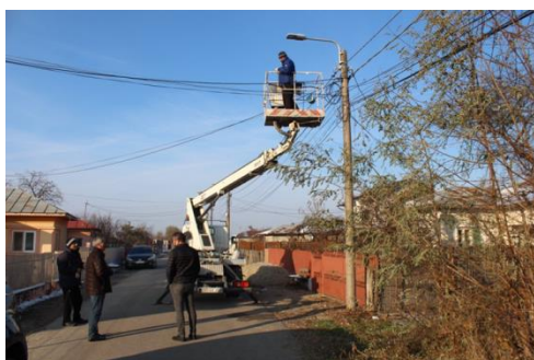
Lucrări de modernizare iluminat public
