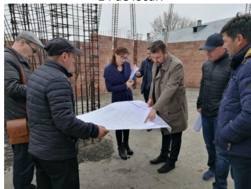
Începerea lucrărilor la Școala Generală Malu Spart
