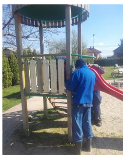
Lucrări de reparații
