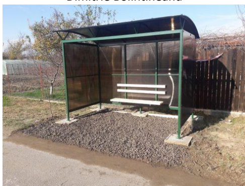
Stații de îmbarcare pe circuitele de transport public orășenesc
