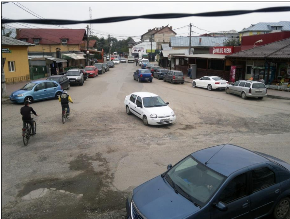
Staționarea autovehiculelor în intersecția DJ601 – DC133
